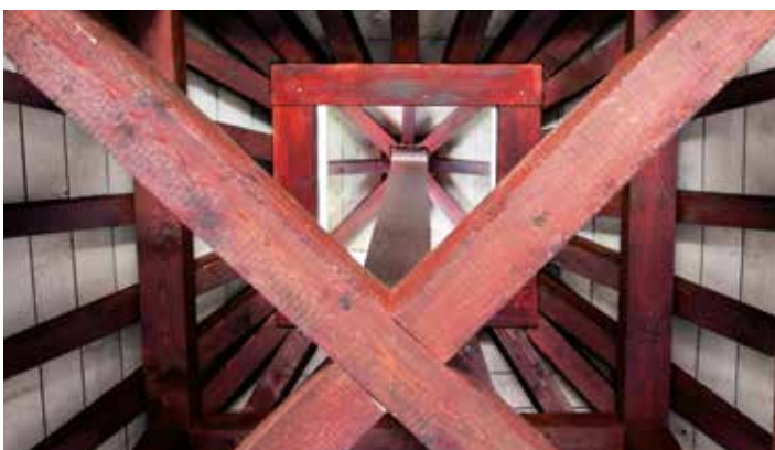
Ricostruzione di una torre di guardia a Pohl. Vista della capriata con travatura radiale, camino aperto per il convogliamento del fumo e stelo massiccio per il coronamento in legno a forma di pigna.
