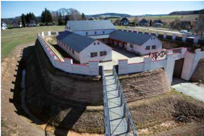
Vallo in terra del primo periodo del limes, realizzato con torba, e travatura reticolare con rivestimento di assi dipinte a imitare dei blocchi di pietra.
